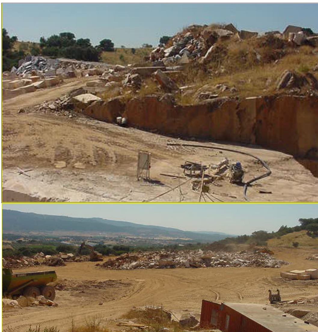
Figuras 5.9.7 e 5.9.8. Fotos dos acessos no interior da pedreira.
