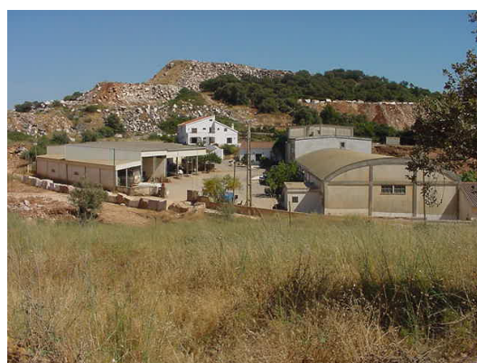
Instalações fabris da empresa (onde se localizam as instalações de apoio)
