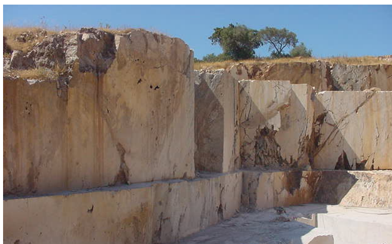
Figura 5.3.4 - Dolomitização secundária na frente Noroeste da pedreira ( à superfície) e mármore creme (ultimo piso).
